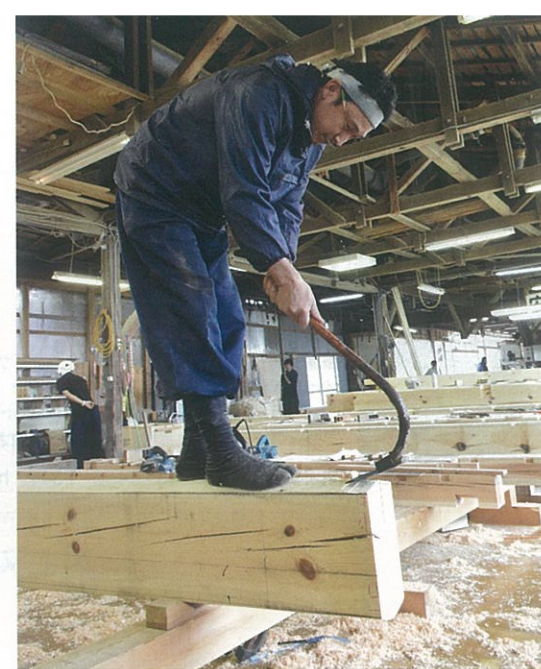
道具は大工の命。時にはチョウナ（写真）やマサカリ、ヤリガンナといった伝統的な道具も実際に使って仕上げる
