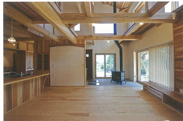
地域を水害から守り続けてきた樹齢85年の南部アカマツを育った姿のままに生かしてタイコ梁に加工した木組みをあらわにした空間
